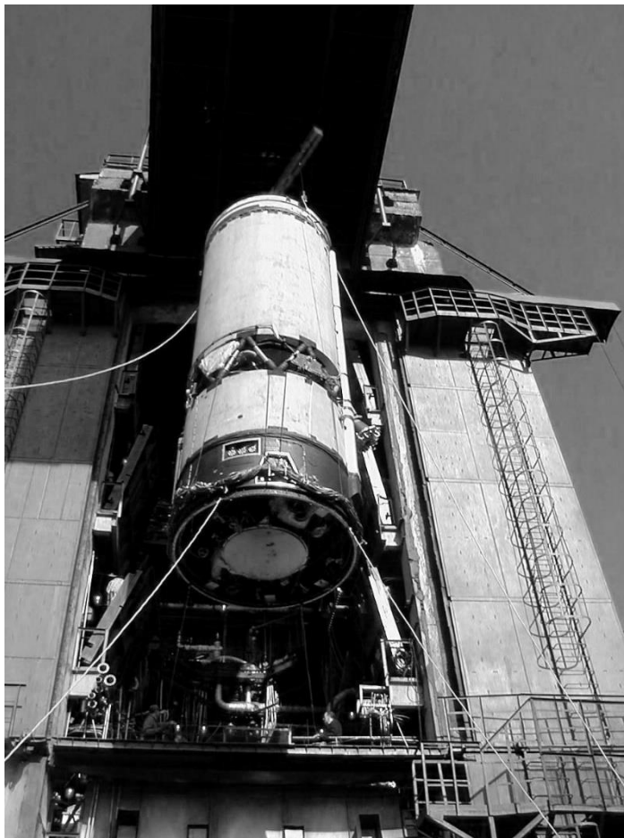
Рис. 2. 36. Установка кислородно-водородного разгонного блока 12КРБ на стенд ВЗ комплекса кислородно-водородных стендов ФКП «НИЦ РКП»
