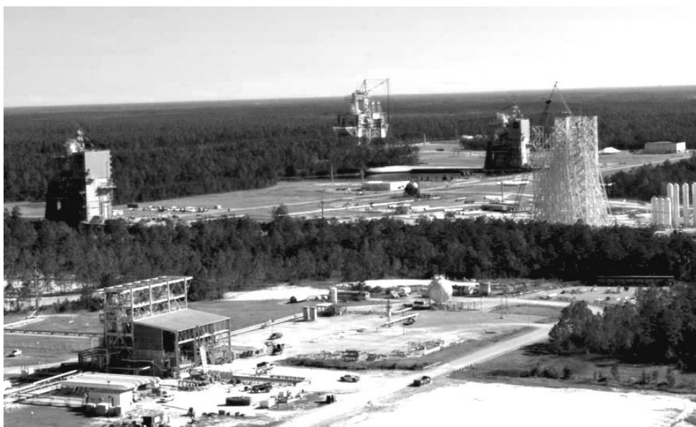
Рис. 2.7. Общий вид территории Центра Стенниса
