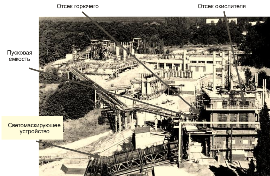
Рис. 2.41. Стенд № 62 для испытаний ЖРД (окислитель – кислород, горючее – керосин, водород, метан) на испытательном комплексе ОАО «КБХА»
