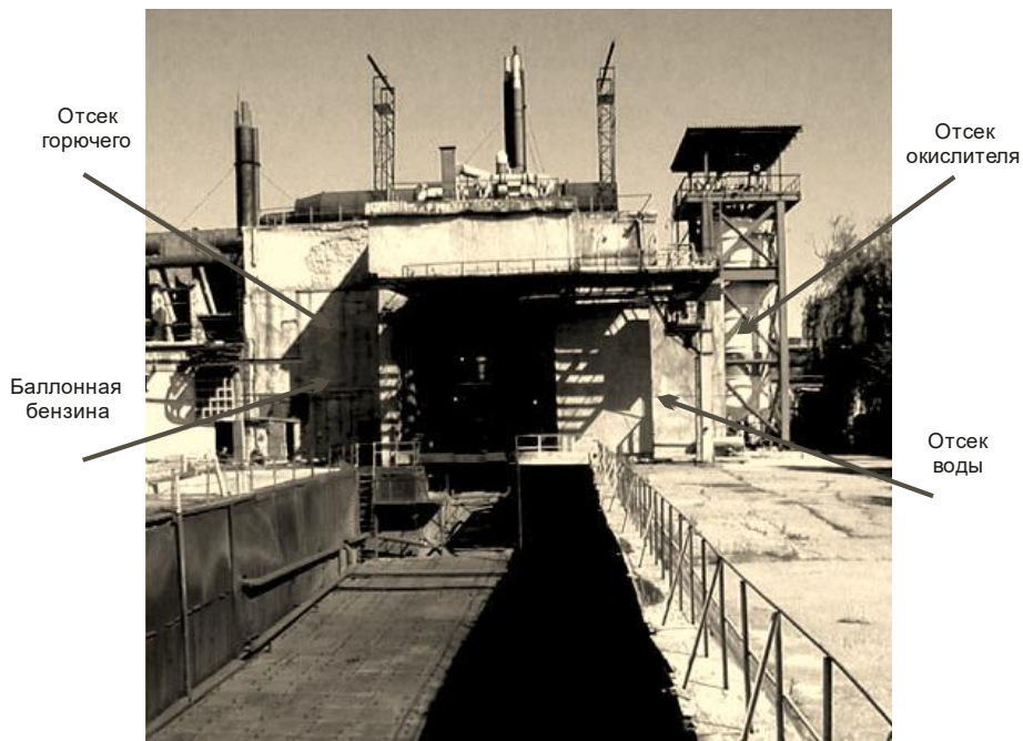
Рис. 2.40. Стенд № 9 для испытаний кислородно-керосиновых ЖРД на испытательном комплексе ОАО «КБХА»
