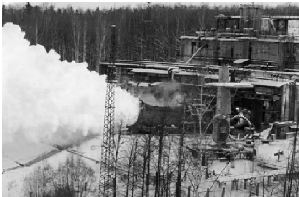
Рис. 2. 35. Испытания кислородно-водородного двигателя на стенде В-2А комплекса кислородно-водородных стендов ФКП «НИЦ РКП»
